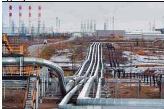
Рис. 2. Внешний вид внутрипромышленного трубопровода на свайных основаниях
